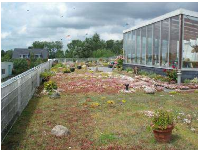
Platz 2 Gruendach Wettbewerb.jpg: Platz 2 - Die intensive Dachbegrünung auf den Neubauten des Gewerbehofes 33 in Kiel wird von den Mietern der Gewerbeflächen unter anderem für Kundenveranstaltungen genutzt. Quelle: Gründach-Wettbewerb
