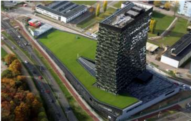
FiftyTwoDegrees (Nijmegen) – Praktische Baustellenerfahrung holländischer Dachgärtner © IGRA
