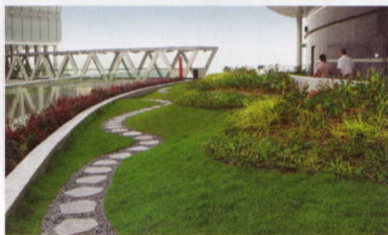
Parkdach: Intensive Dachbegrünung auf dem New-Providence-Gebäude in London
