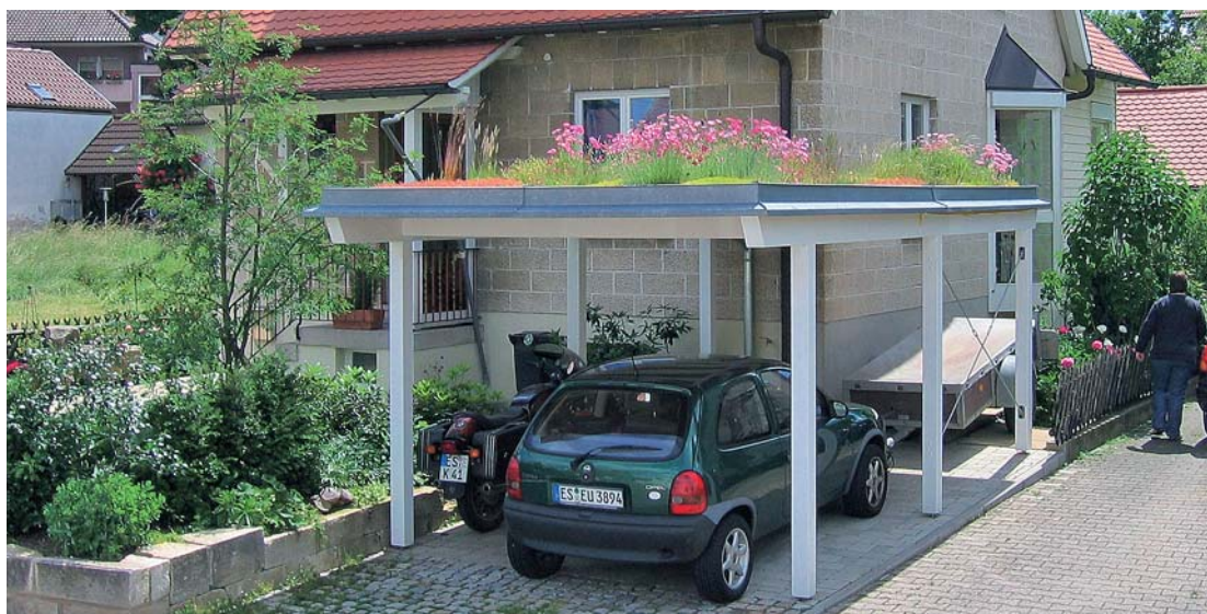
Das Bremer Förderprogramm unterstützt auch kleinflächige Dachbegrünungen
